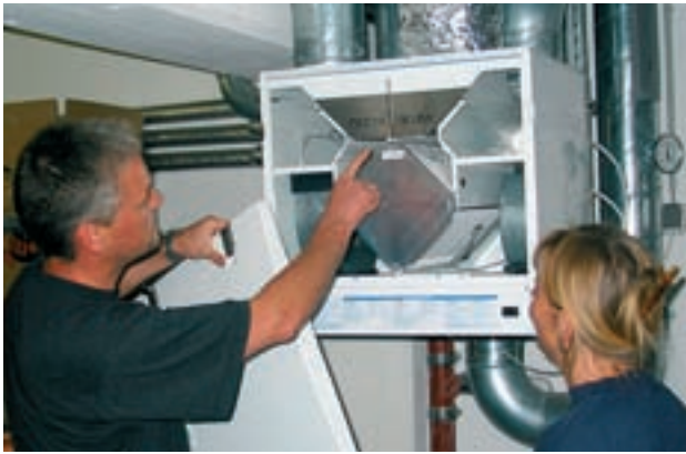
Wartung Lüftungsanlage
