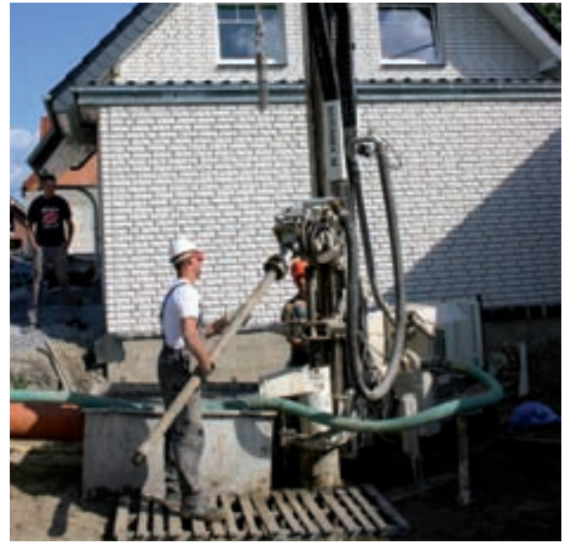
Verlegung Erdwärmesonde
