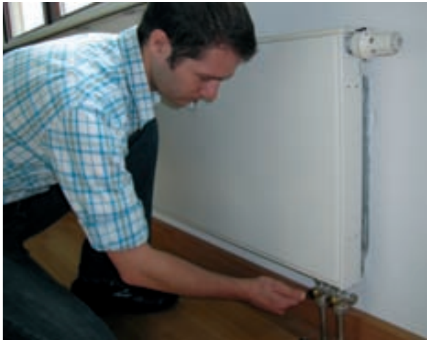
Hydraulischer Abgleich
