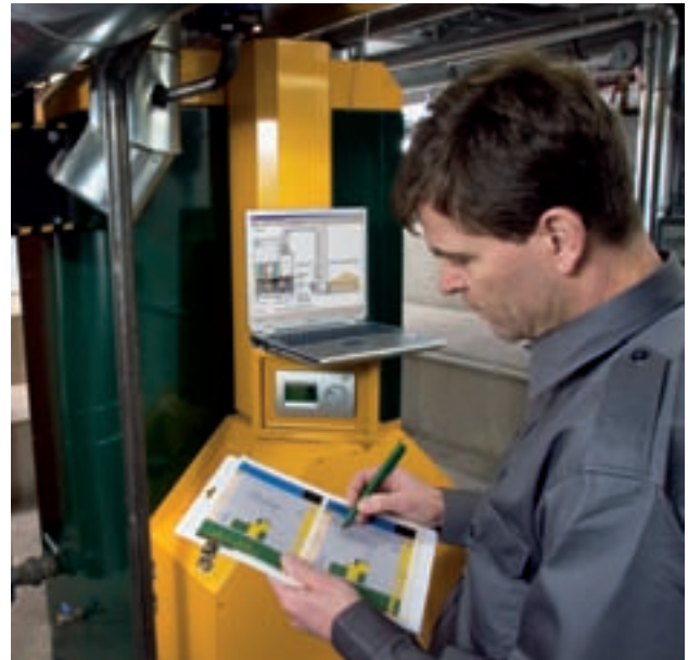
Inbetriebnahme einer Heizungsanlage
