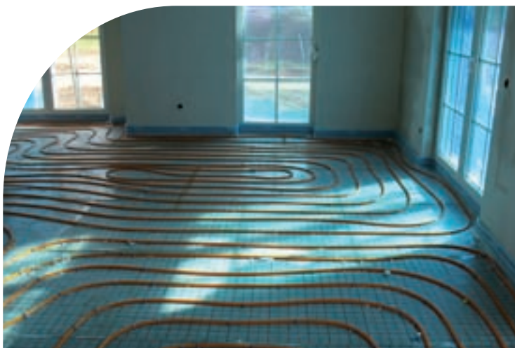
Fußbodenheizung
