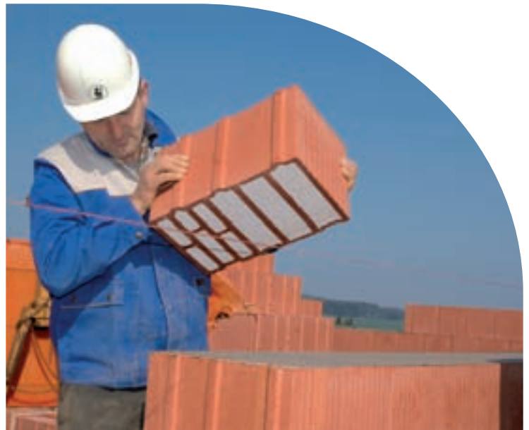
Monolithische Mauerwerkswand
