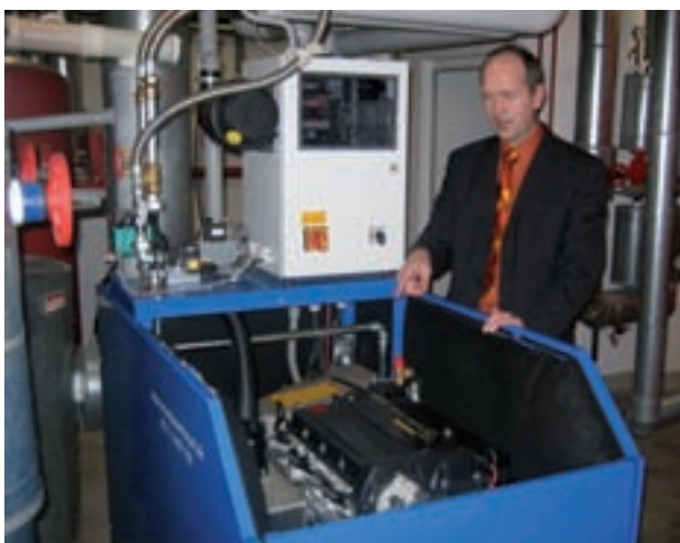
Blockheizkraftwerk Mehrfamilienhaus
