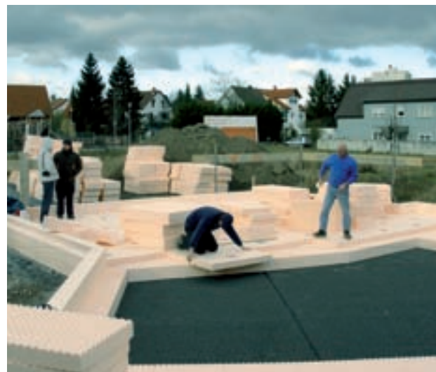
Unterseitige Dämmung der Bodenplatte
